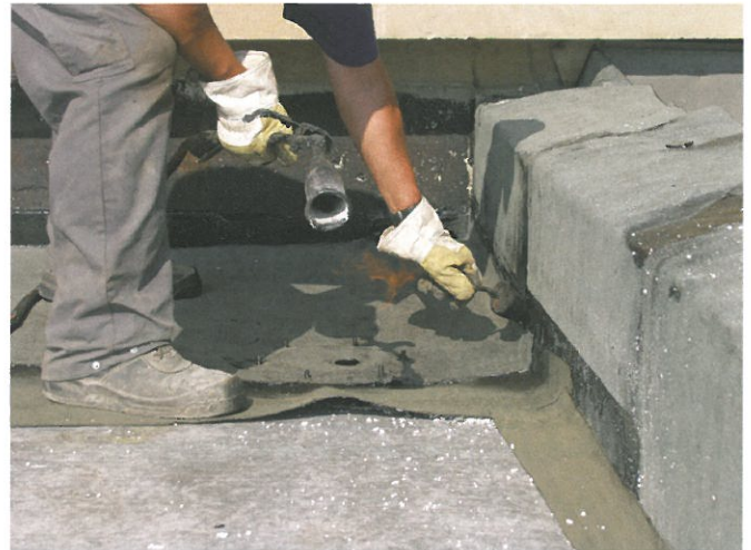
Mit besonderer Sorgfalt wurde die Abdichtung an den Abläufen ausgeführt.
