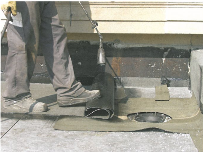
Nach gründlicher Überlegung entschieden Bauherr und Architekt unbeheizte Abläufe vorzusehen.
