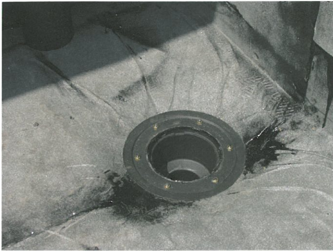
Die Gefälledämmung sorgt für die Wasserführung Richtung Gully.
