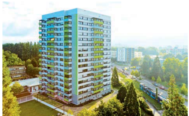
Freiburg, Bugginger Straße Passivhaussanierung Hochhaus, 1950er Jahre Bauherr: Freiburger Stadtbau GmbH Planung: Architekturbüro Rombach, Kirchzarten
