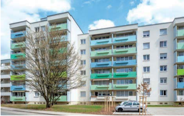
Fürth, FinkenPark Fürth Wohnsiedlung, 1968/1970er Jahre Bauherr: Evangelisches Siedlungswerk Bayern, Nürnberg Planung: ESW Bauplanung GmbH, Nürnberg
